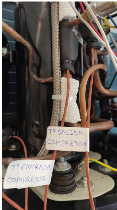
Figura 3.1: Montaje de termopares.
